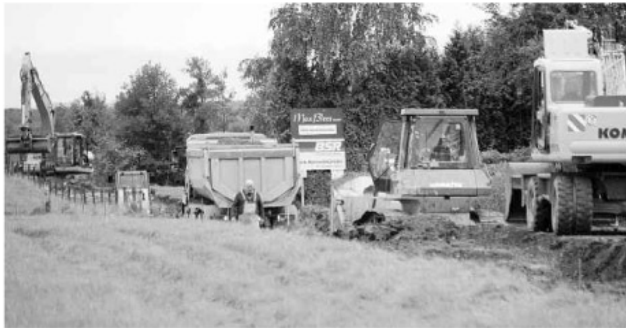
Geballter Einsatz von Arbeitsgerät: Die zusätzliche Zufahrt in den Breiniger Steinbruch von der L 12 aus soll bereits in wenigen Tagen fertiggestellt sein; die Ortslage Kornelimünster wird vom Lkw-Verkehr entlastet.
